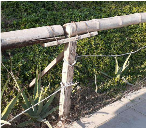
Barandas hechas con caña brava y alambres, podría ocasionar algún daño.
