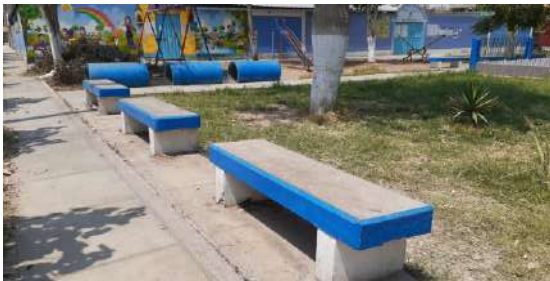
Mobiliario de concreto se ve en buen estado y recién pintado.
