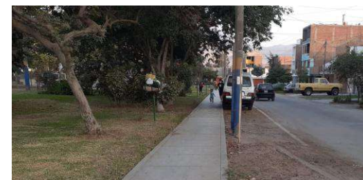
Las veredas no cuentan con el ancho mínimo de 1.50m para el buen tránsito de personas con discapacidad,
