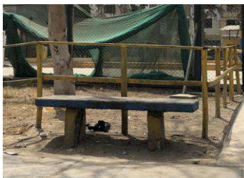
Mobiliario de descanso en mal estado.
