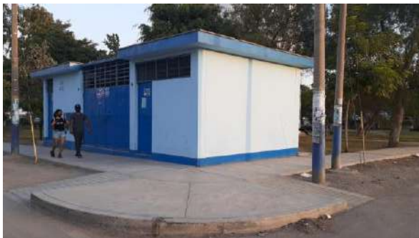
Cuenta con rampas en las 4 esquinas del parque.
