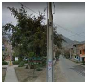
Instalaciones eléctricas mal instaladas.
