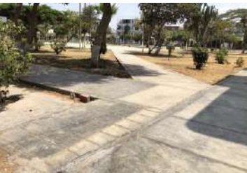
Existen rampas para personas con discapacidad.
